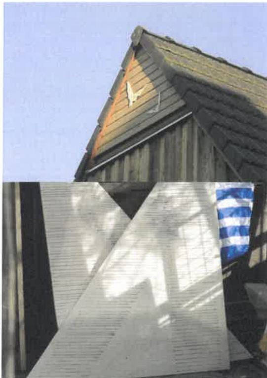
Fledermausquartier: Rückwand aus 1cm Sperrholz, genietet und natürlich unbehandelt
